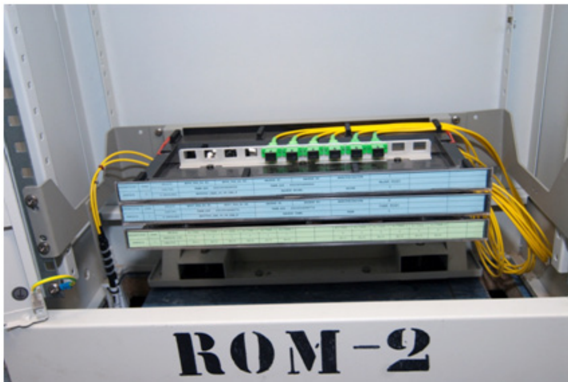
Imagen 36: Bastidor de fibra óptica
