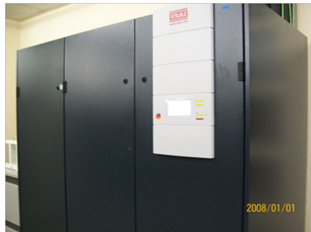
Figura 52: Una de las nuevas máquinas de aire acondicionado
